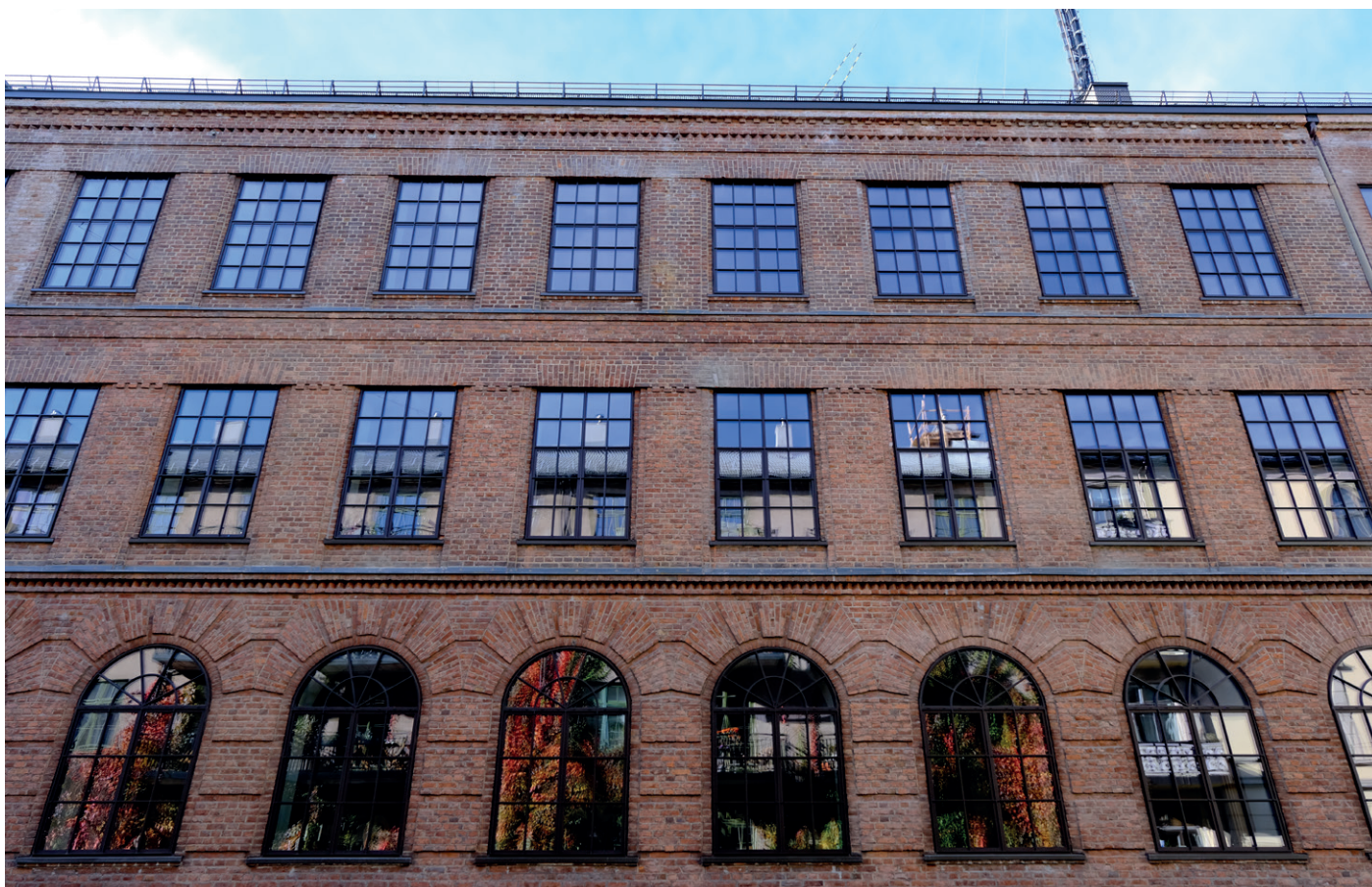
Fasaden langs Åsaveien er bevart slik den opprinnelig ble oppført.
