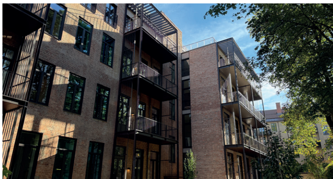
Det er også oppført et tilbygg i bakgården, og montert verandaer på fasaden.
