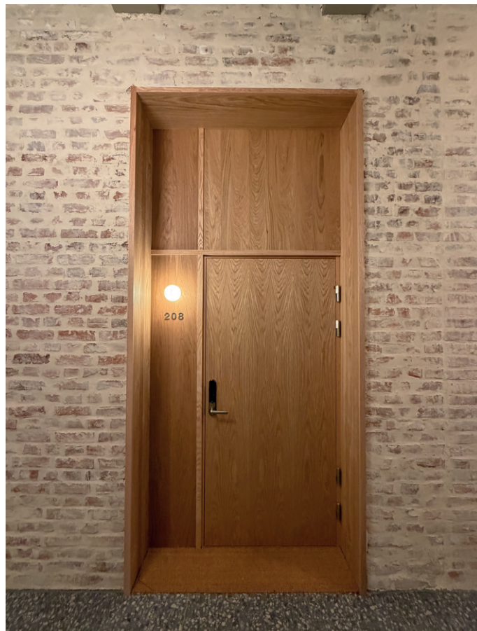
Teglsteinen i fellesarealene er behandlet med sekkeskuring.
